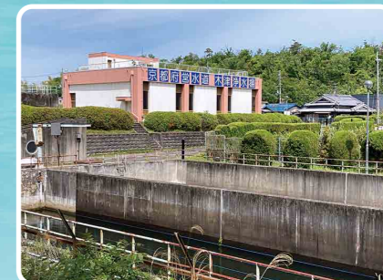
木津川の表流水を水源に水道水を作り、京田辺・木津川・八幡市、精華町に供給しています。場所＝木津川市吐師医王寺
