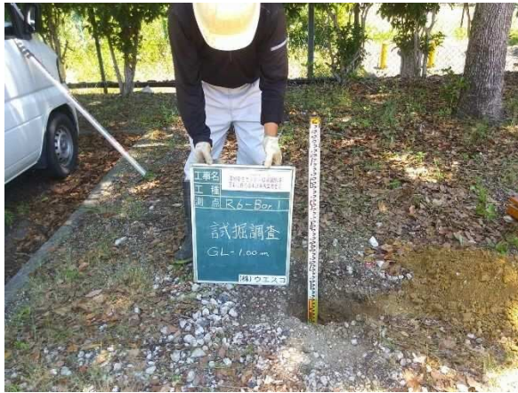
図 4.1-3 R6-Bor.1 での試掘確認状況(埋設管なし)
