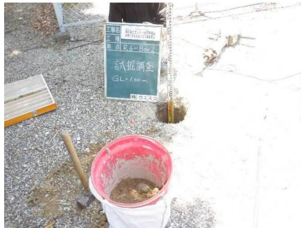
図 4.1-4 R6-Bor.2 での試掘確認状況(埋設管なし)
