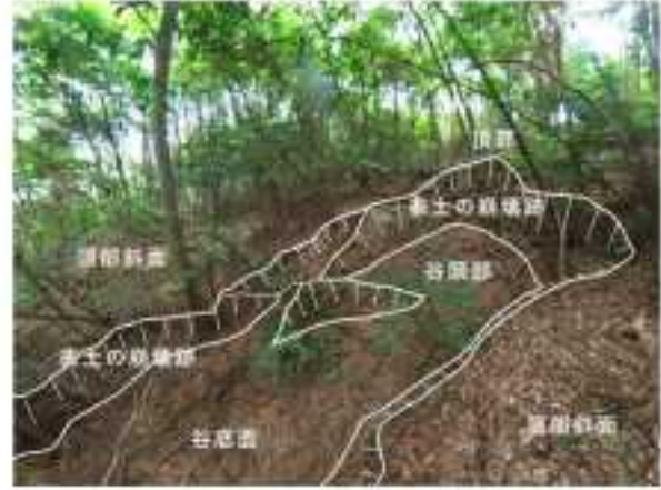
図 80 表土崩壊状況(1号墳北側斜面)
