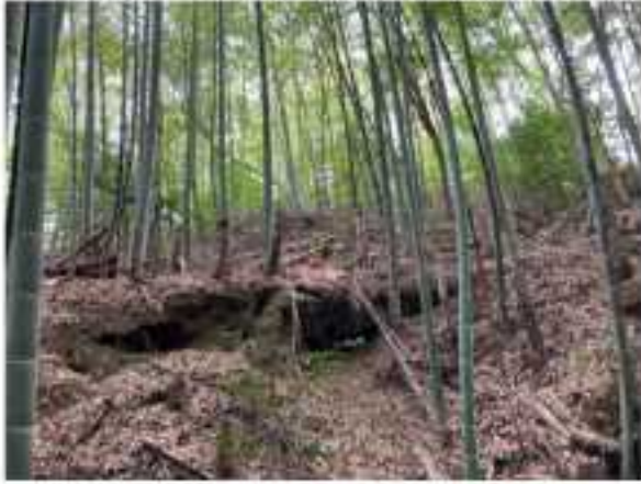
図 79 表土崩壊状況(3号墳北側斜面)
