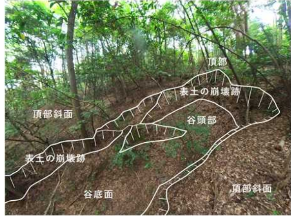
図 80 表土崩壊状況(1号墳北側斜面)
