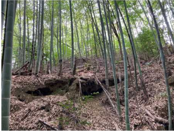
図 79 表土崩壊状況(3号墳北側斜面)
