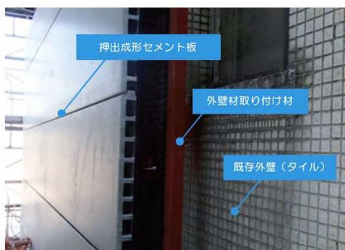
パネル被覆改修工法で既存外壁を別の仕上げ材で覆う
