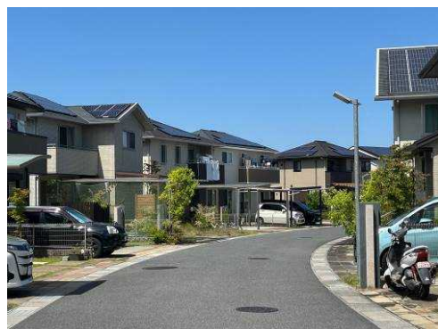
図2-4 要請者負担方式による無電柱化(民間住宅地開発)
