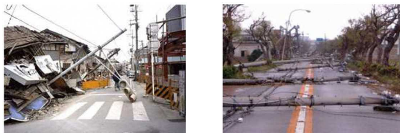
図 1－1 災害時に避難や緊急車両の通行を妨げる電柱の倒壊（国土交通省HP）
