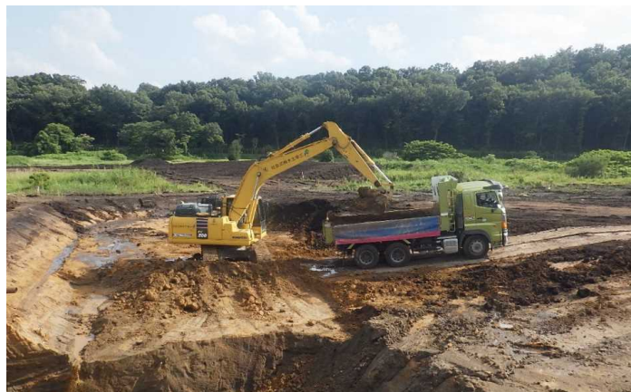
敷地造成工事（イメージ）
