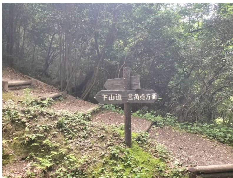
⑫-② 甘南備山内 擬木製標識柱 文字の書き直し・追加 両矢 H200×W1000
