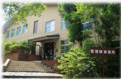
野外活動センター 管理棟
