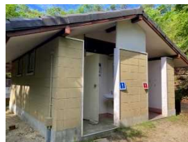
屋外トイレ（和式）
