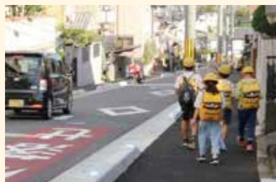
幅の拡張や縁石を設けたことで安全性が向上した歩道
