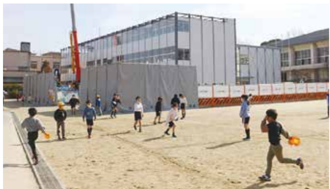
田辺小学校北校舎改修に伴い使用される仮設校舎
