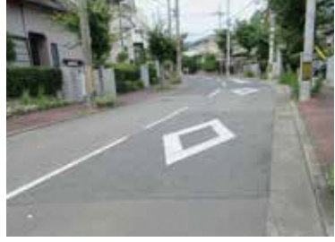
修繕求めた花住坂内の道路
