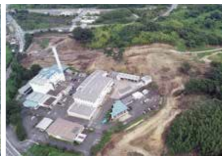
造成工事の今の様子
