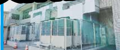
アリーナ床下に冷暖房の空気を送風する大型エアコン
