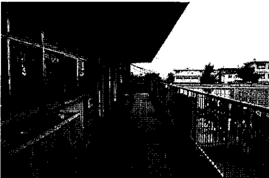
鉄筋コンクリート造園舎 2階廊下
