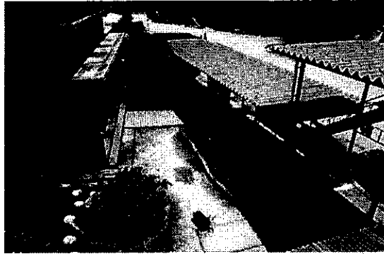
鉄骨造園舎及び渡り廊下
