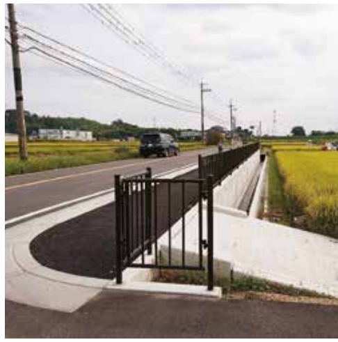
草内美泥排水路
