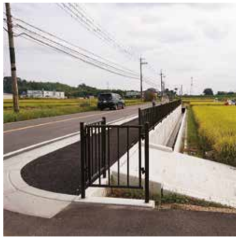
草内美泥排水路
