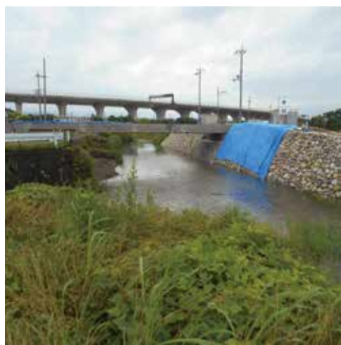
防賀川改修工事の現場 (令和2年6月14日撮影)
