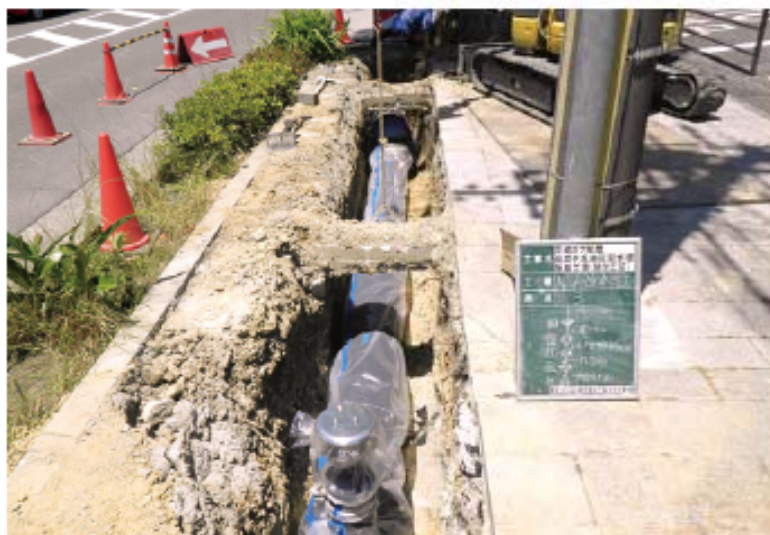
水道配水管改良工事
