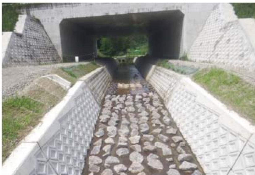
河川改修(遠藤川)
