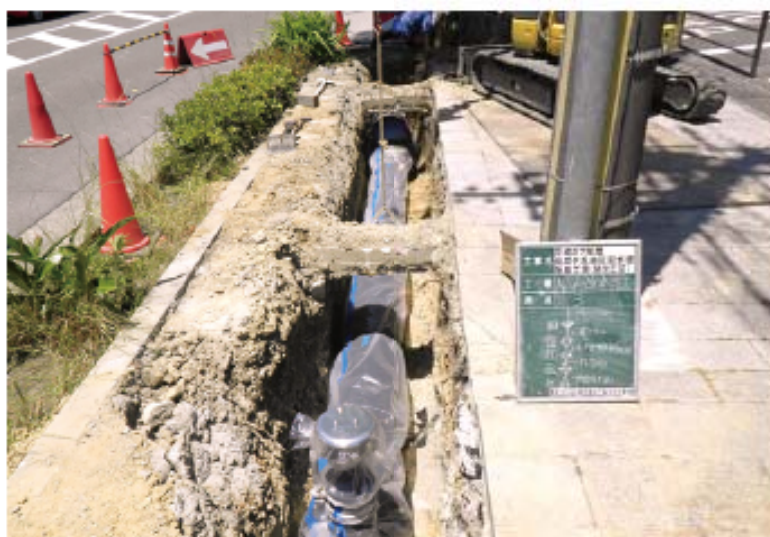
水道配水管改良工事
