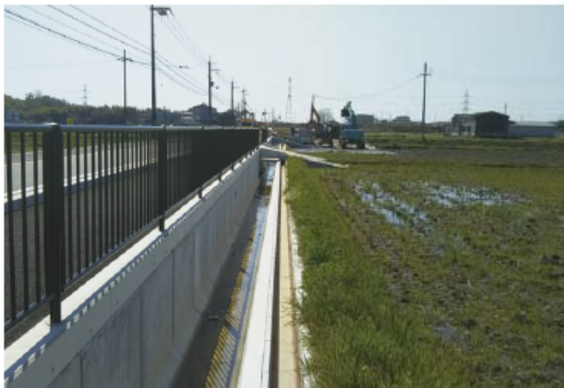
排水路整備(草内美泥)
