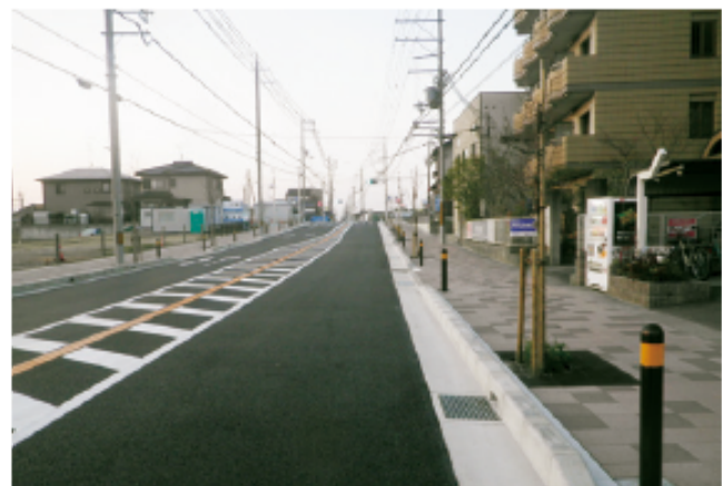
道路改良(南田辺三山木駅前線)
