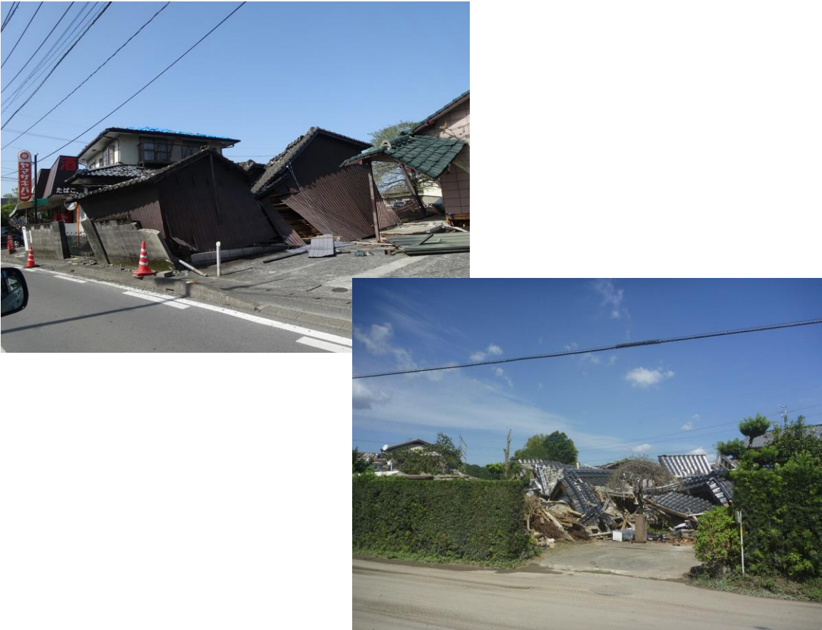
写真：熊本地震被害状況（平成28年）
