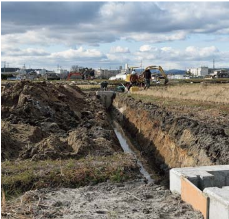
東地区農地乾田化事業工事
