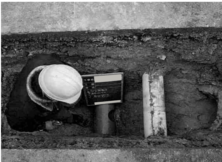
支管取付部 穿孔完了状況
