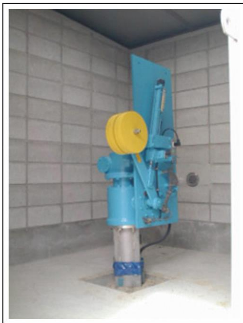
緊急遮断弁 (写真は田辺低区配水池)
