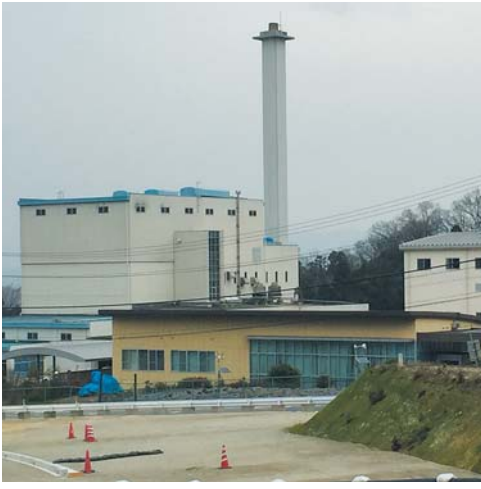
ごみ焼却場 (甘南備園)
