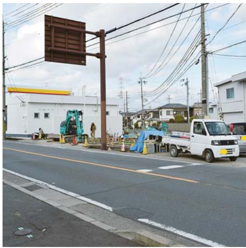
工事中の新茶屋前交差点
