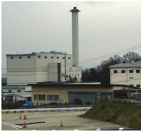
ごみ焼却場 (甘南備園)
