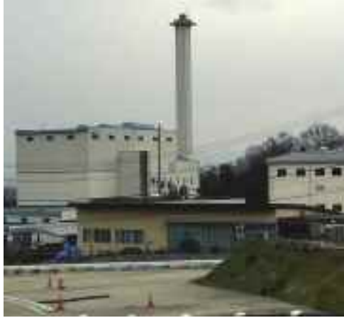
ごみ焼却場 (甘南備園)
