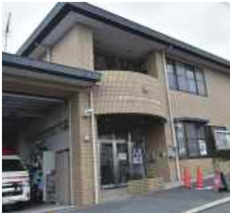
消防署北部分署
