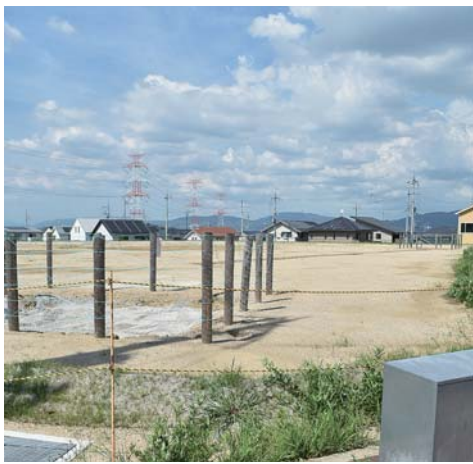
建設中の認定こども園
