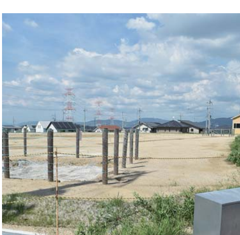
建設中の認定こども園
