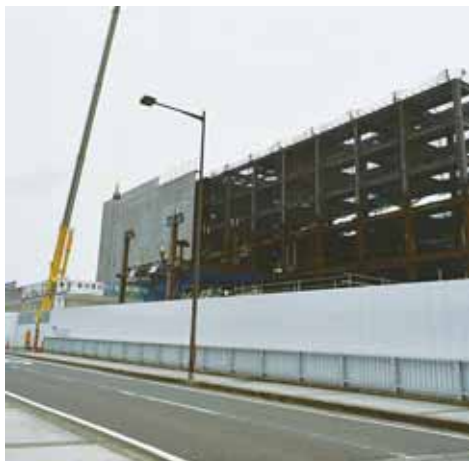
建設中の鉱泉浴場とホテル(松井山手)
