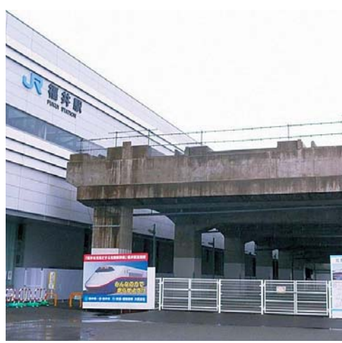
建設中の北陸新幹線福井駅
