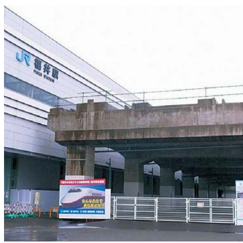
建設中の北陸新幹線福井駅
