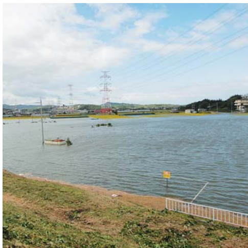
10月の台風で冠水した農地 (山本地区)
