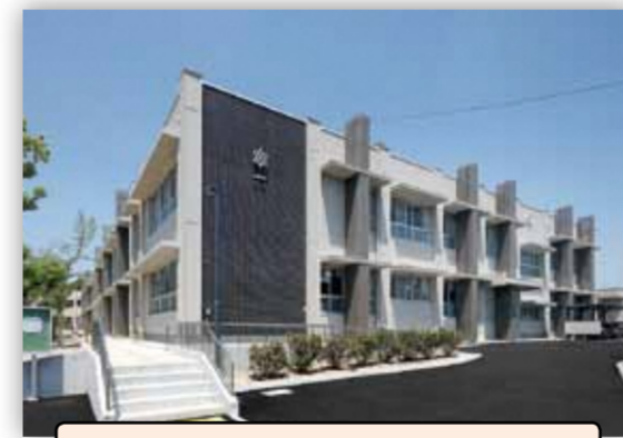
新しくなった三山木小学校東校舎棟
