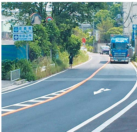
大阪府側から見た国道307号
