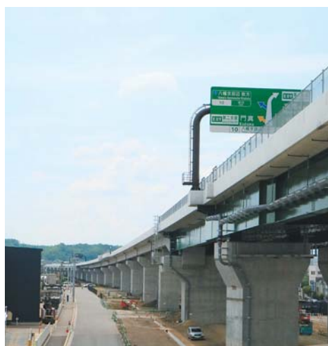
開通した新名神高速道路の八幡・京田辺～城陽間(大住地内)
