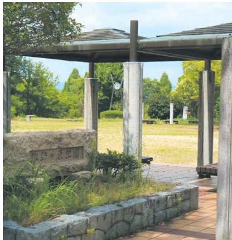
地域防災拠点として整備が進められる諏訪ヶ原公園
