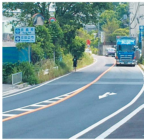
大阪府側から見た国道307号
