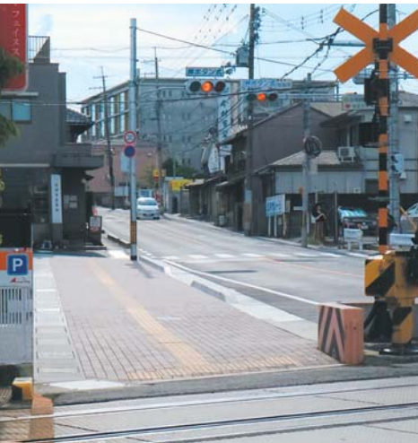
整備された歩道と増設された信号機 (JR信楽街道路切)
