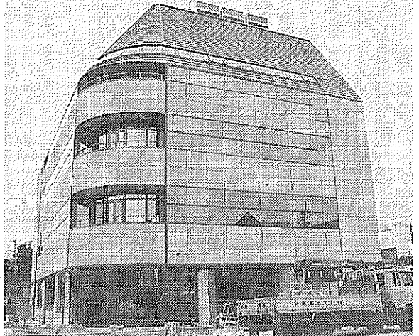
建設が進む複合型商工会館
