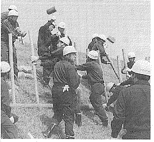
「杭打ち積み土のう工法」に取り組む消防団員ら
