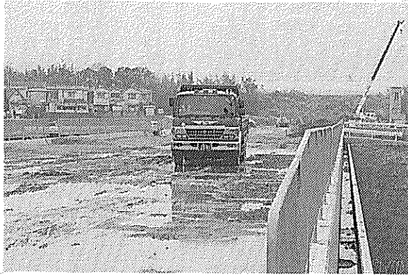
工事が進む町道薪新田辺線(天津神川の交差点付近)
