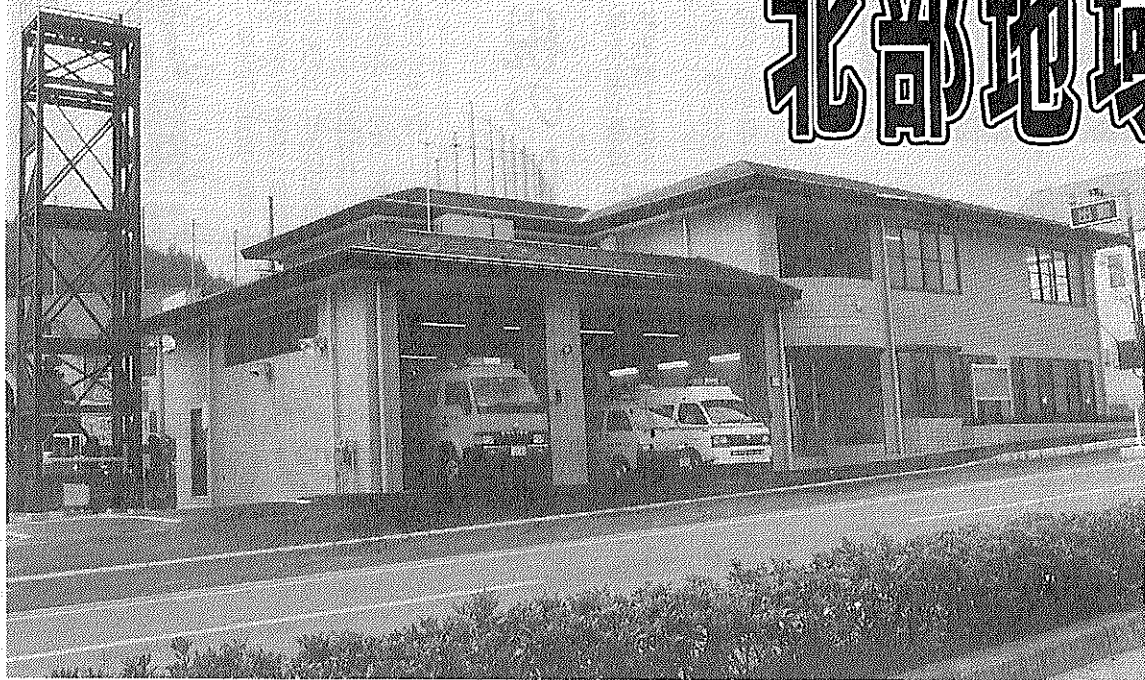
消防署北部出張所が完成。一層充実した消防体制で、安全で快適なまちづくりをめざす。
