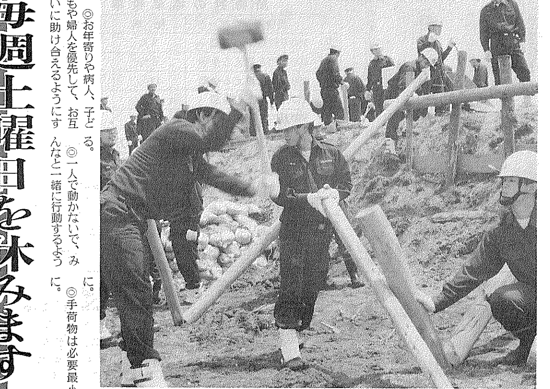
水防訓練で杭打積み土のう工法に取り組む消防団・署員
