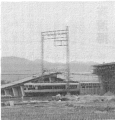
1日も早い完成が望まれる国道307号バイパス(近鉄・JRをまたぐ高架橋工事)
