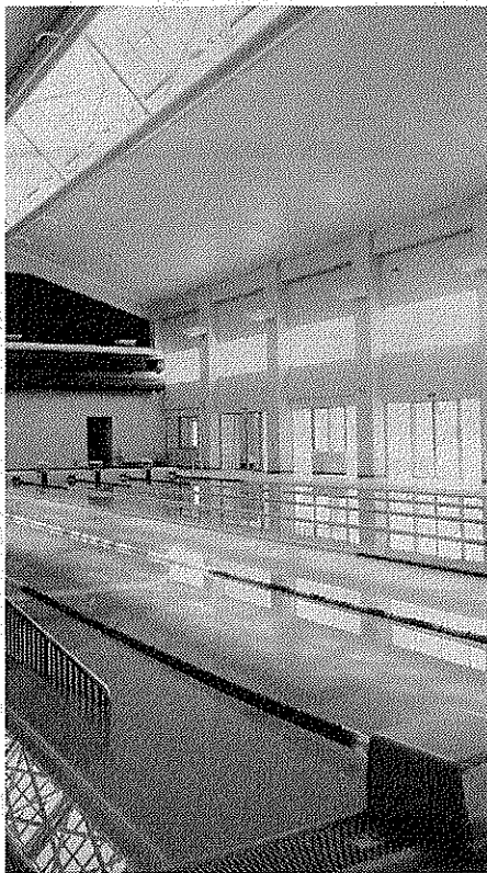
室内プール 夏期以外は温水プールとして1年中利用できます
