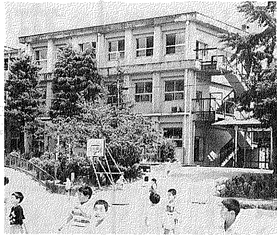
内外壁の塗り替えなど大修理される田辺小学校南校舎(田辺小学校で)
