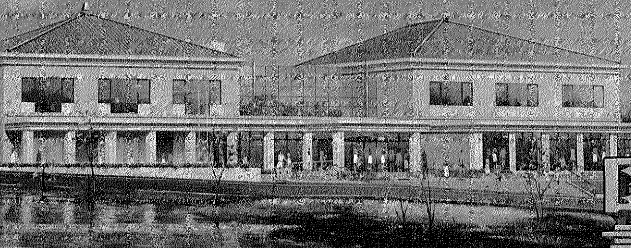
多目的施設 北部地域のコミュニティの拠点「北部住民センター」は4月に完成します
