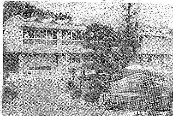
【上】完成した普賢寺小体育館 【右】旧体育館
