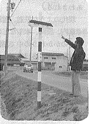
測量が終わりルート予定地に建てられた道路の中心を示す標識(大住・岡村)
